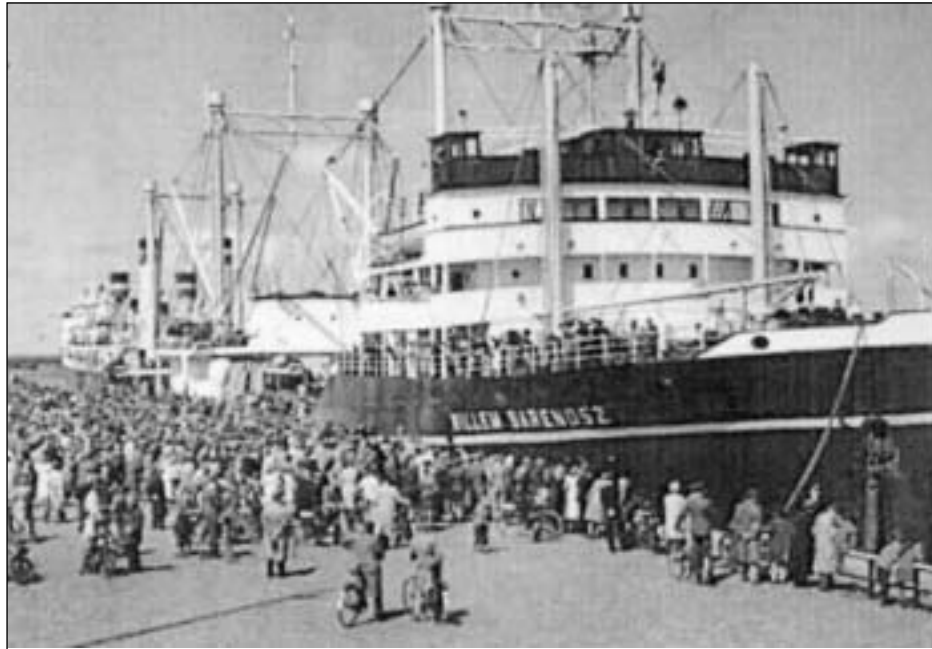
“Willem Barendsz” var bygdur sum oljutangaskip í Gøteborg í Svøríki í 1931. Støddin var 10.409 t. Longdin var 155 m, breiddin 20 m. og dýpdin 9,5m. Maskinorkan var 2 x2400 hk B&W. Skipið varð í 1945 keypt til Hollands og bygt um til hvalaskip. Sum tað sæst var forvitenskapurin stórur. Nógv fólk á bryggjuni.
