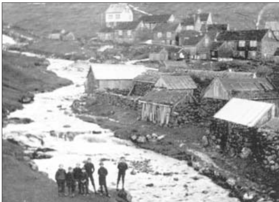
Byggin Oyndarfjørður í 1920-unum.
