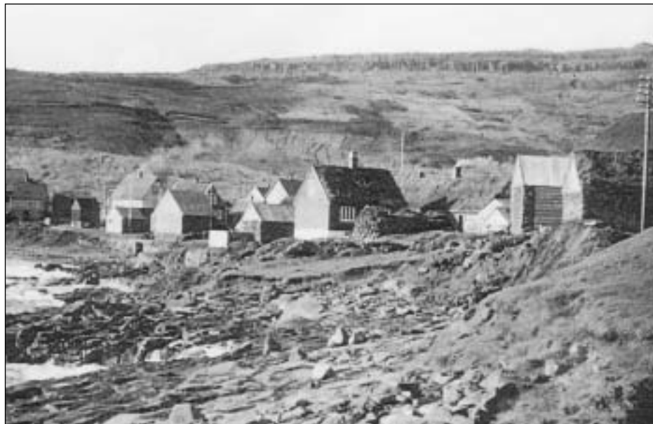
Húsini har Niðri eru tey, har tað sær út sum at tað er bygt omaná skorsteinin. Tað vísti seg at skorsteinurin av ov lágur. So var settur ein leypur uttan botn omaná skorsteinin, og trupulleikin varð loystur!
