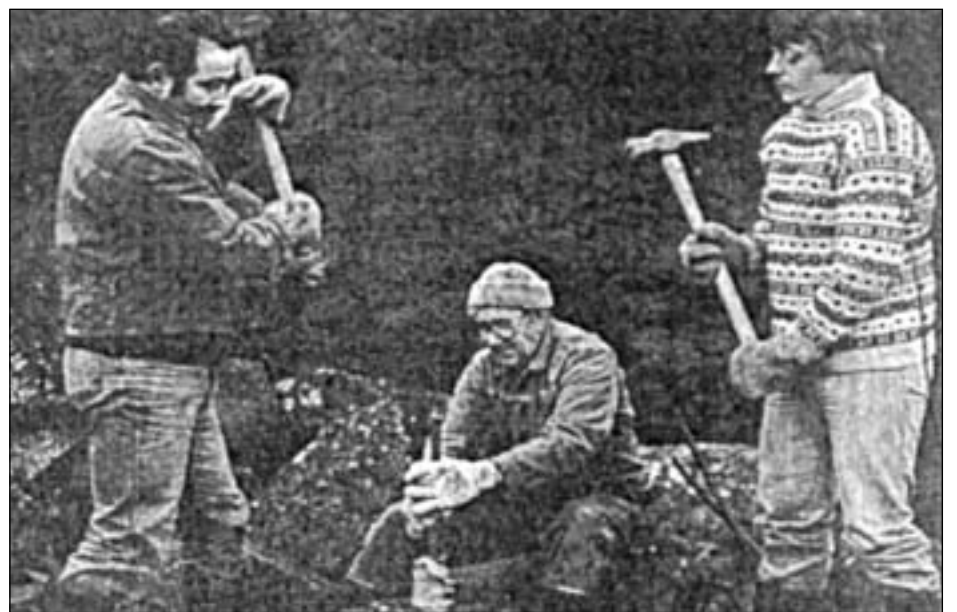
Vegarbeiði í "gomlum døgum". Her skal borast hol til spreinging. Ein heldur borinum og hinir skiftast at sláa við sleggju.
