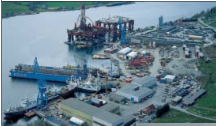
WESTCON's skips- og offshoreverft i Ølen
