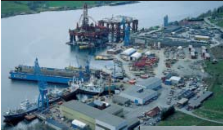
WESTCON's skips- og offshoreverft i Ølen
